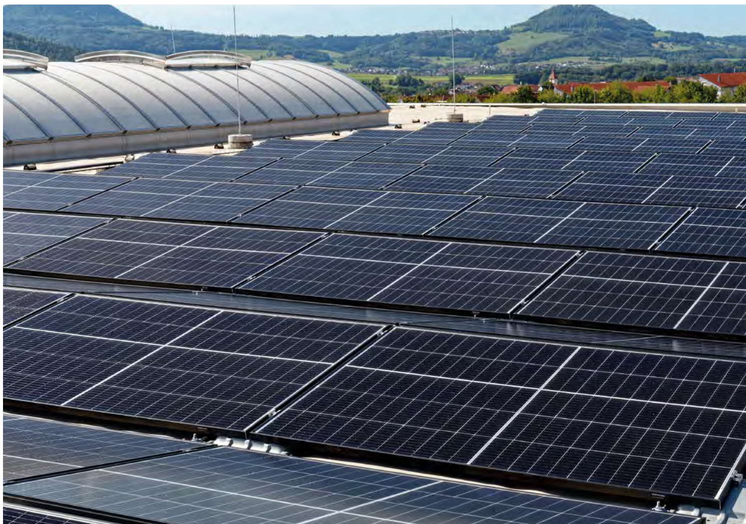
Das PV-Flachdachmontagesystem iFIX von voestalpine, ausgestattet mit REGUPOL solar Schutzlagen, bietet zuverlässigen Schutz für Abdichtungssysteme von Flachdächern
