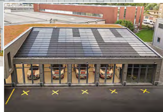
„Sunskin Roof Lap“ Indach-System für Dächer mit einer Neigung von 15° bis 60°
