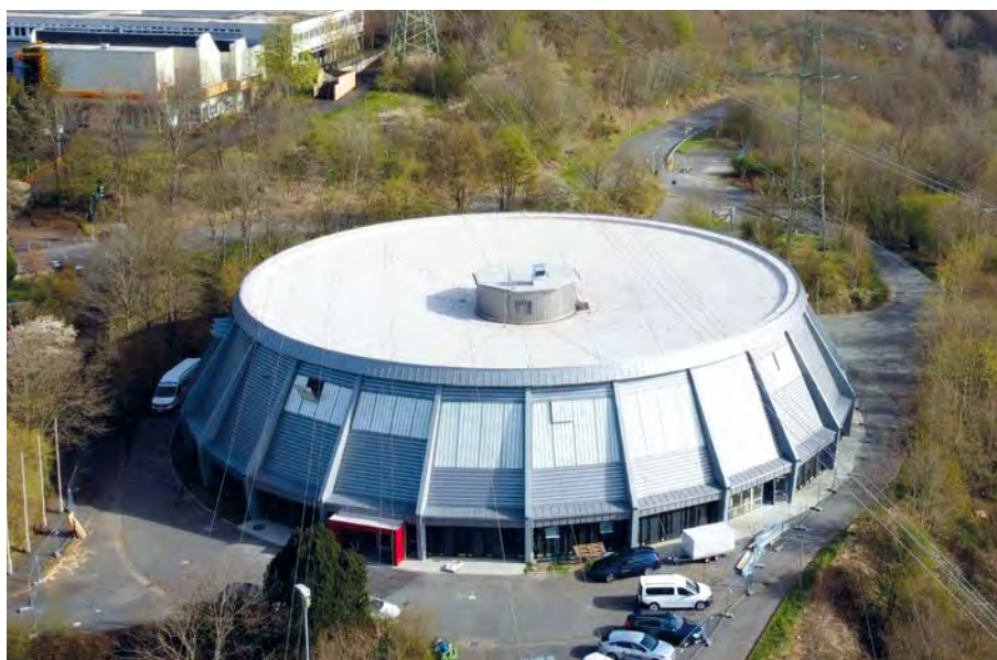
Das Kegelschalendach der Rundturnhalle in Siegen wurde im Rahmen einer Komplettsanierung mit der Kunststoffabdichtungsbahn Sarnafil® TG 76-18 FSA von Sika abgedichtet
