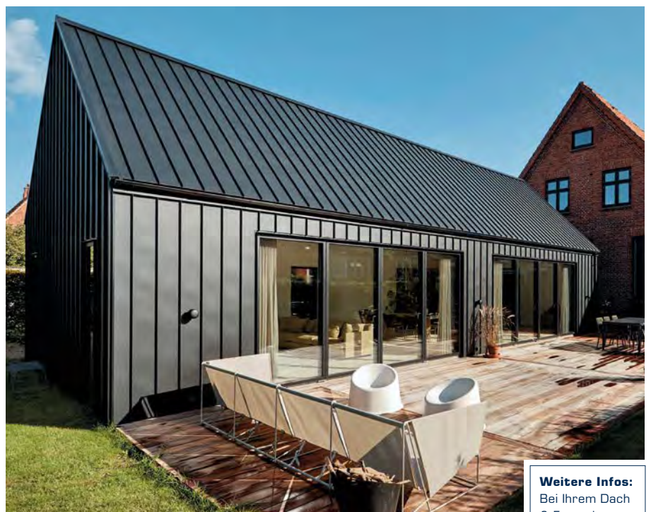
Wohnhausbau eingedeckt und bekleidet mit DS Nordic Klickfalz in Schwarz
