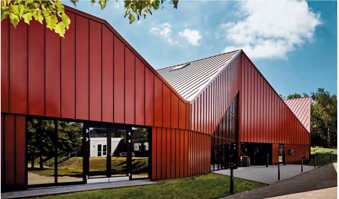
Sporteinrichtung eingedeckt und bekleidet mit der DS Nordic Klickfalz in Rot
