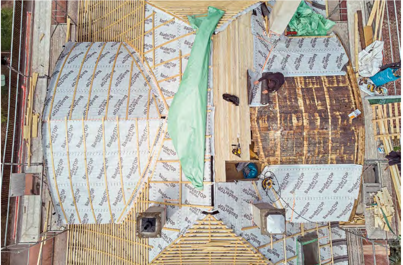
BauderPIR als Aufsparrendämmung
