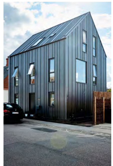
Wohnhaus eingedeckt und bekleidet mit der DS Nordic Klickfalz in Dunkelsilber
