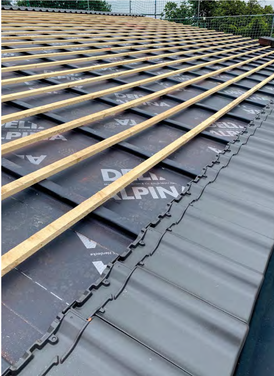
DELTA®-ALPINA ausgeführt als Klasse 1 mit DELTA®-ALPINA BAND für die Einbindung der Konterlatte
