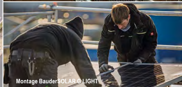
Montage BauderSOLAR G LIGHT
